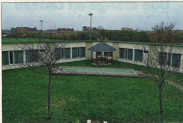
Le Centre Éducatif Fermé de Mulhouse a été inauguré en 2008, à côté du quartier Fonderie.
