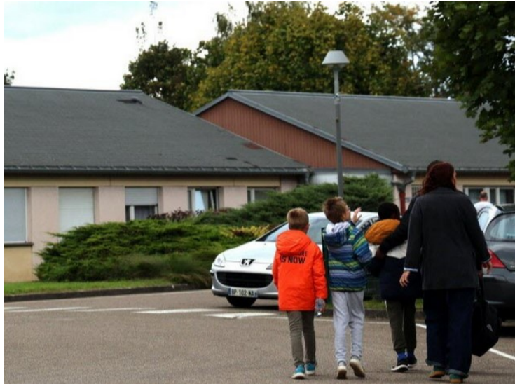
Les bâtiments du foyer de l'enfance qui seront détruits durant les futurs travaux engagés pour sa rénovation pour un montant de 28 millions. Photo Cédric Joubert
