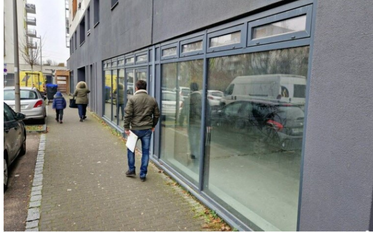
Au rez-de-chaussée de l'immeuble situé 7, rue Olympe-de-Gouges, une conciergerie verra le jour cette année.
