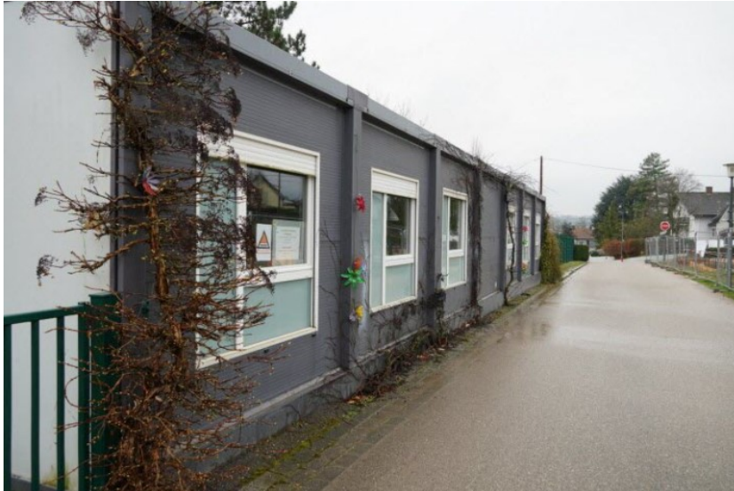
L'Institut médico-éducatif de Wissembourg accueille ses pensionnaires dans deux constructions modulaires. Photo Louis Roche
